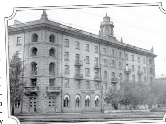
Многоквартирный дом ИЕТЭЦ-1 по проекту архитектора Менде
