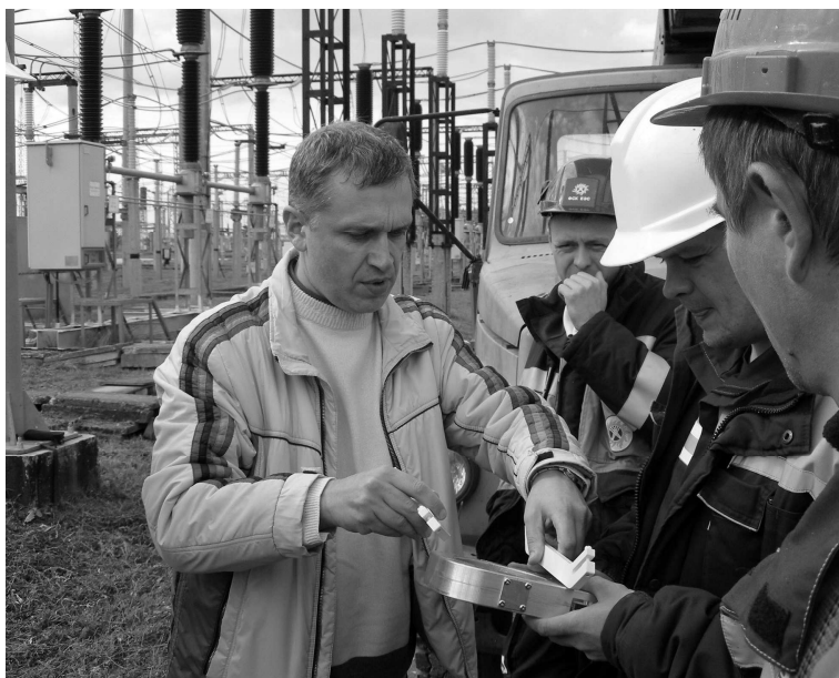
В.Д. Лебедев готовит цифровой трансформатор тока к установке на подстанции «Нижегородская»
