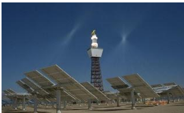
Рис 2. Система гелиостатов СЭС Solar Two
