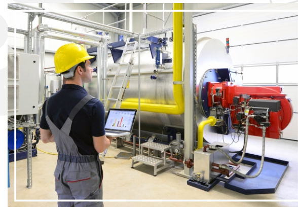
Приемка оборудования в эксплуатацию после монтажа
