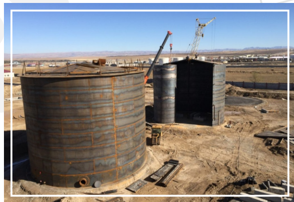
Ремонт вертикальных цилиндрических резервуаров
