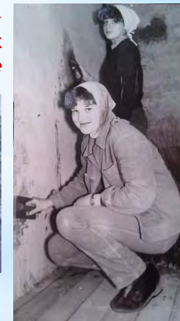
ССО «Градиент» отделка жилых домов на селе
