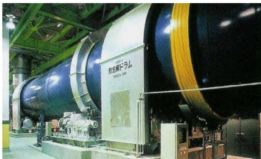
Рисунок 6.9 - Реактор пиролиза на заводе термической переработки ТКО Toyohashi в Японии
