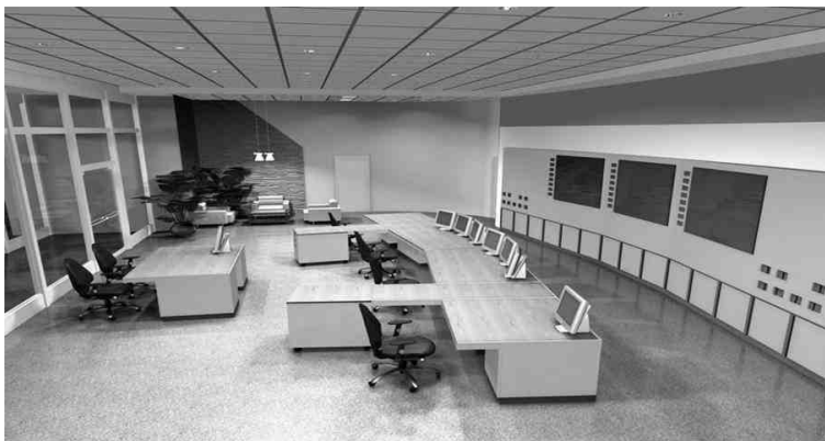
Рис. 3. План расположения и оснащения рабочих мест операторов БЩУ нового поколения с дисплейным способом управления энергоблоком
