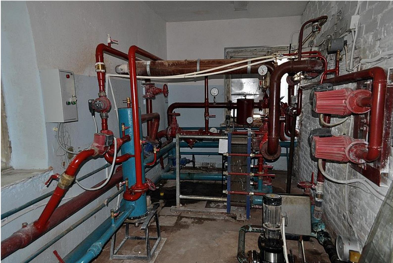
Рисунок 4.12 – Внешний вид теплового пункта абонента «гараж»
